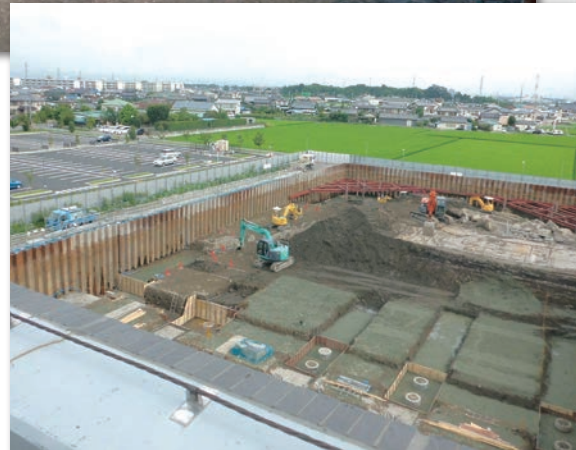
2. 新黒沢病院は免震の建物なので、地上から5m70cmも掘らなければなりません。そこで、土留めを目的としたシートパイル(鉄の壁)が作られ、その中で作業が進められています。こんなに深く掘っても地下室はありません。(8月)
