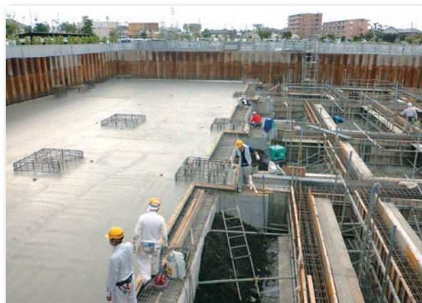
5. 5工区の免震ピットの床が見えてきました。(9月)
