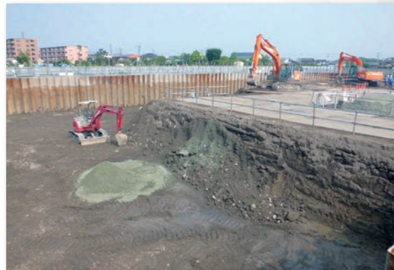
1. 建設予定地です。大型の重機が入る通路部分に、鉄板が敷き詰められています。(6月)
