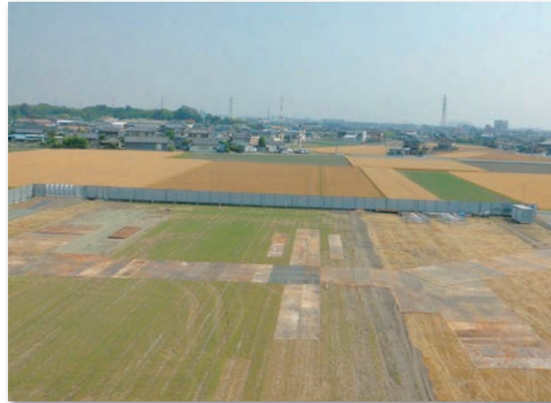
1. 建設予定地です。大型の重機が入る通路部分に、鉄板が敷き詰められています。(6月)
