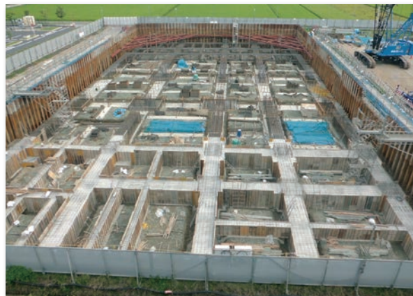
4. 工事場所を5つの工区に分けて作業が進められています。手前側が5工区です。型枠が作られています。ちなみに、この建物で使われる鉄筋の80%がこの地下に使われるとのこと。(9月)
